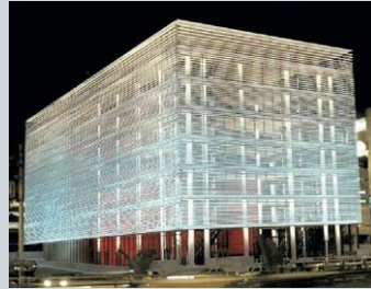
Στέγη Γραμμάτων & Τεχνών
